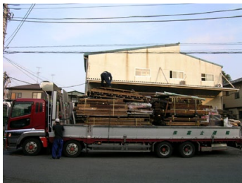
13.5tトラックに積込まれる部材
