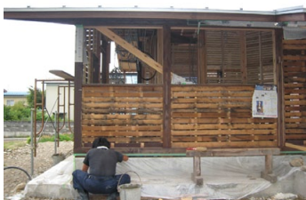
湯沢での移築工事が進む
