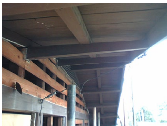
解体時の軒裏の様子
