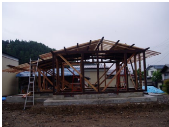
湯沢で再建される軸組み
