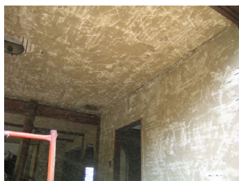
内部土壁を掻き落した状態
