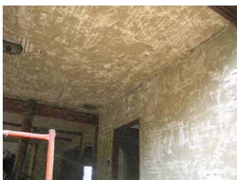
内部土壁を掻き落した状態
