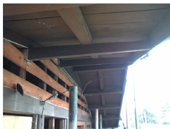
解体時の軒裏の様子
