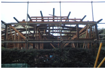
軸組みだけになった外観
